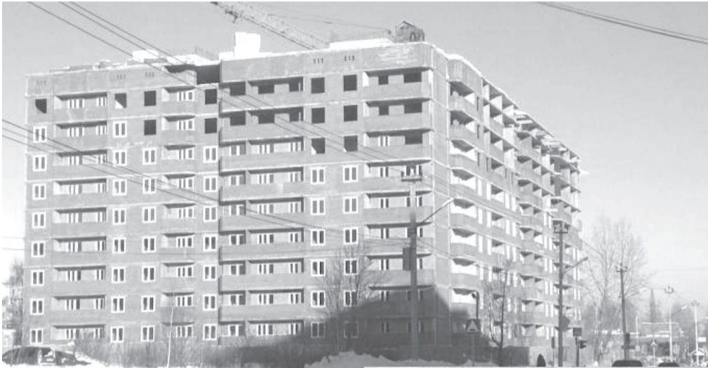
Дом по улице Декабристов, 6. Работы продолжаются.
